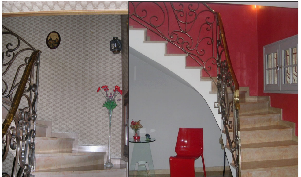
Avant et après... Cette montée d'escalier est métamorphosée par ce mur réalisé en béton ciré rouge.
